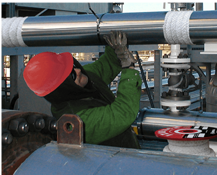
1 - шнур IZOPACK; 2 - проволоочное крепление; 3 - обшивка тканью; 4 - нитки; 5 - крепление обшивки проволокой или "хомутами"; 6 - внешняя обкладка
